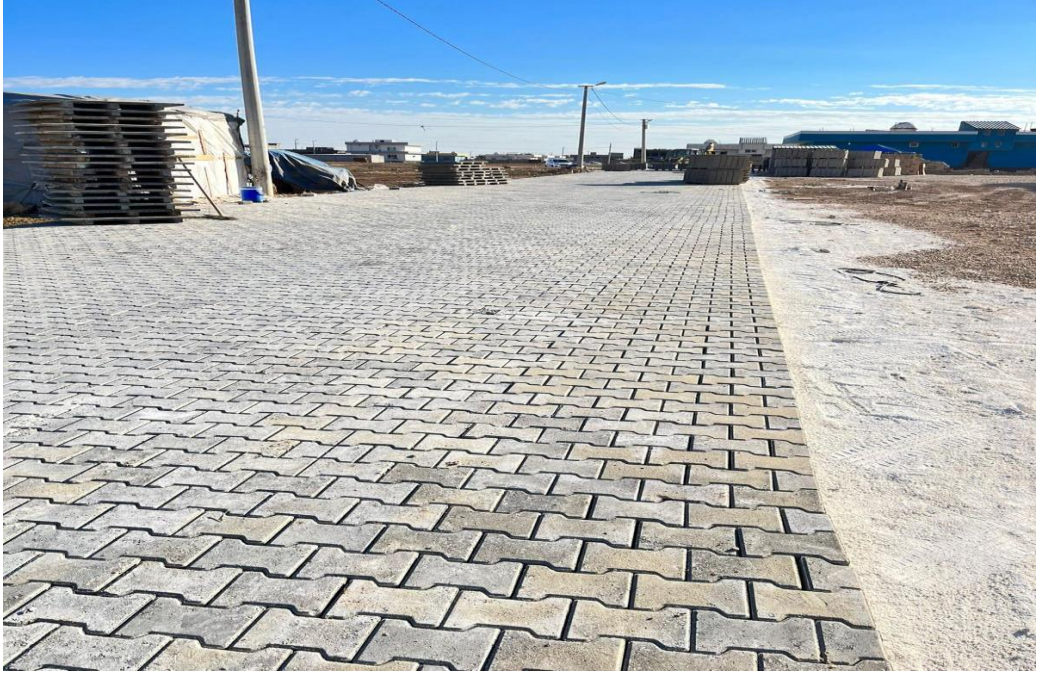
Göllü Mahallesi Parke Çalışması
