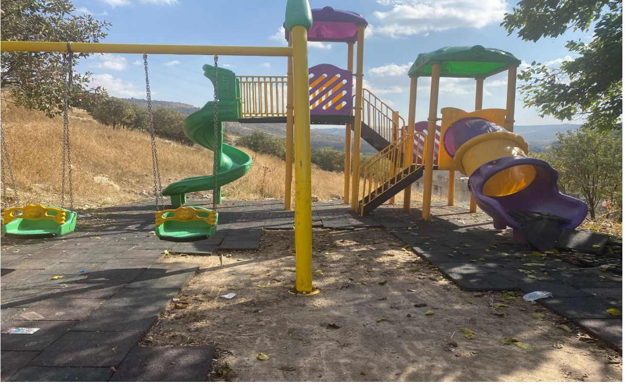
31-) Özlüce Mahallesi deforme olan çocuk oyun parkı ve kauçuk zemin tadilatı yapıldı.
