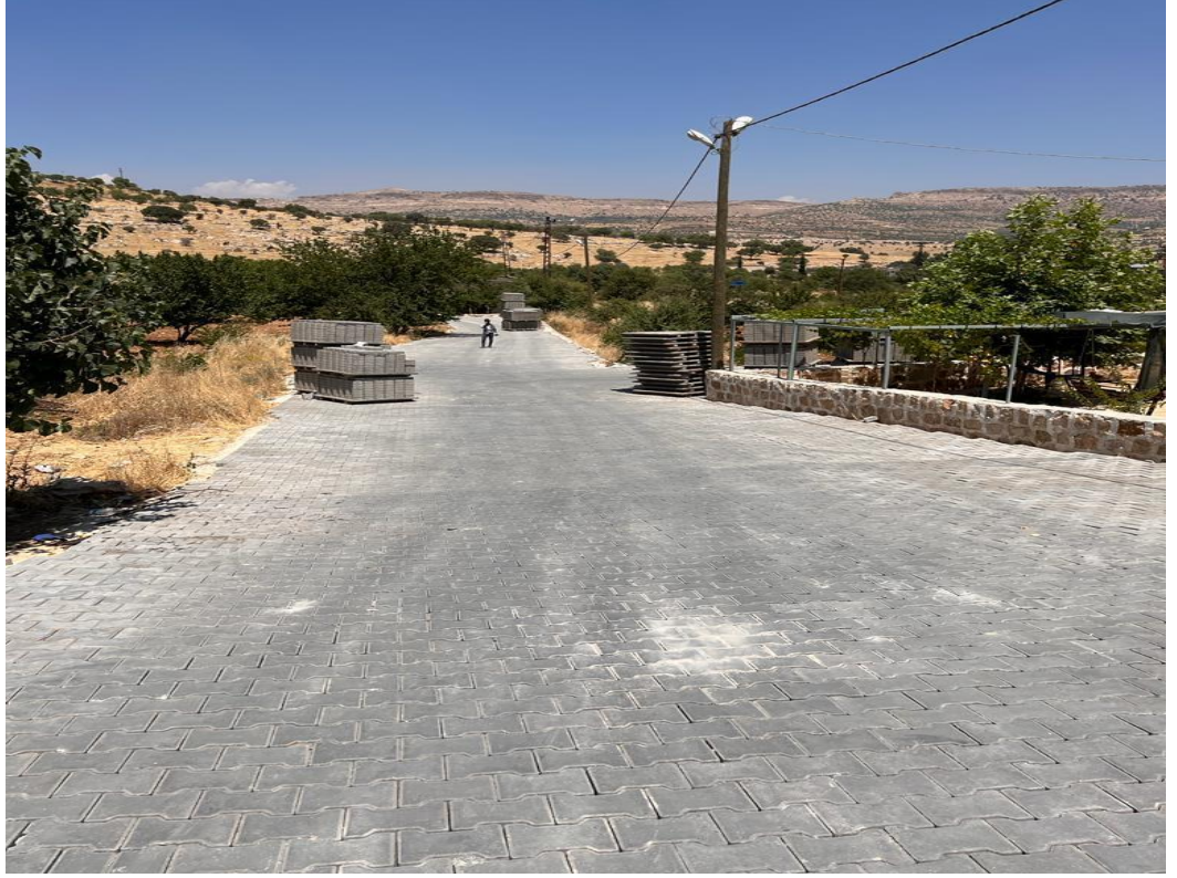
Hamzabey Mahallesi Parke Çalışması
