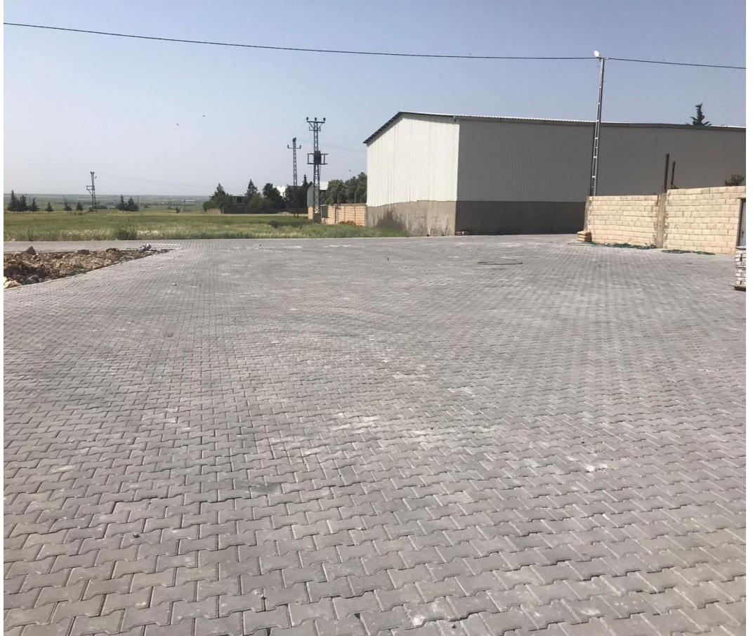
İstasyon Mahallesi Parke Çalışması
