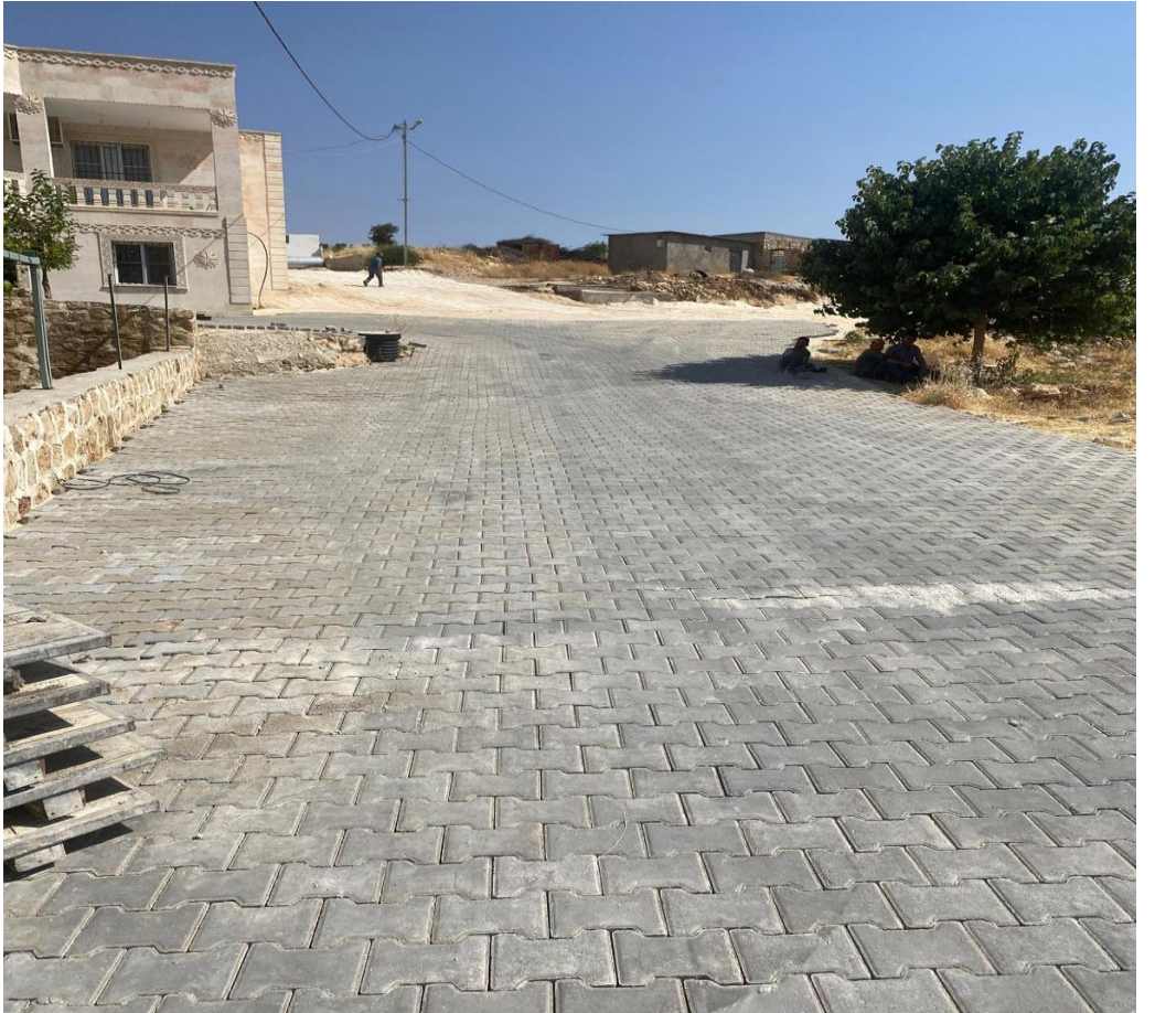
Hamzabey Mahallesi Parke Çalışması
